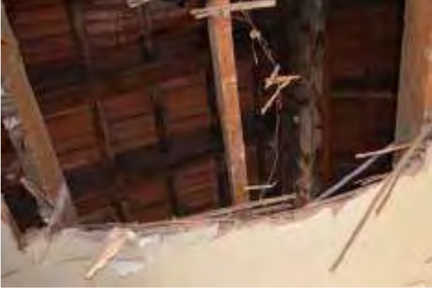
Fotoğraf 18. Bağdadi tekniğinde yapılmış tavadan detay.
