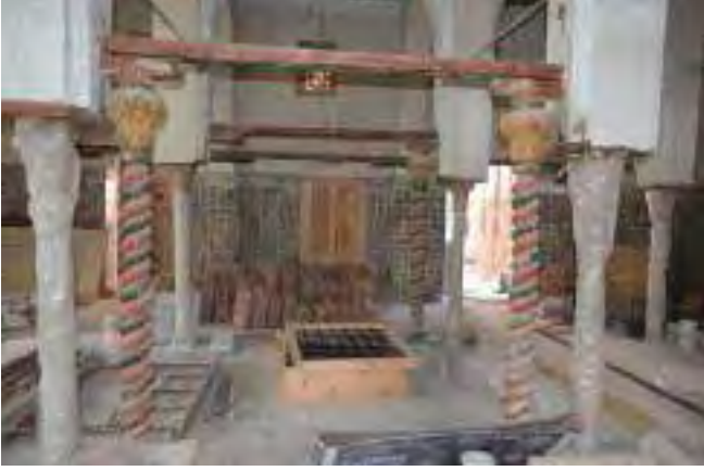
Fotoğraf 24. Mahfili taşıyan ahşap sütunlar.
