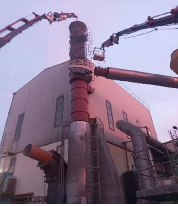
Şekil 6. Ekonomizerin mevcut bacaya montajı
