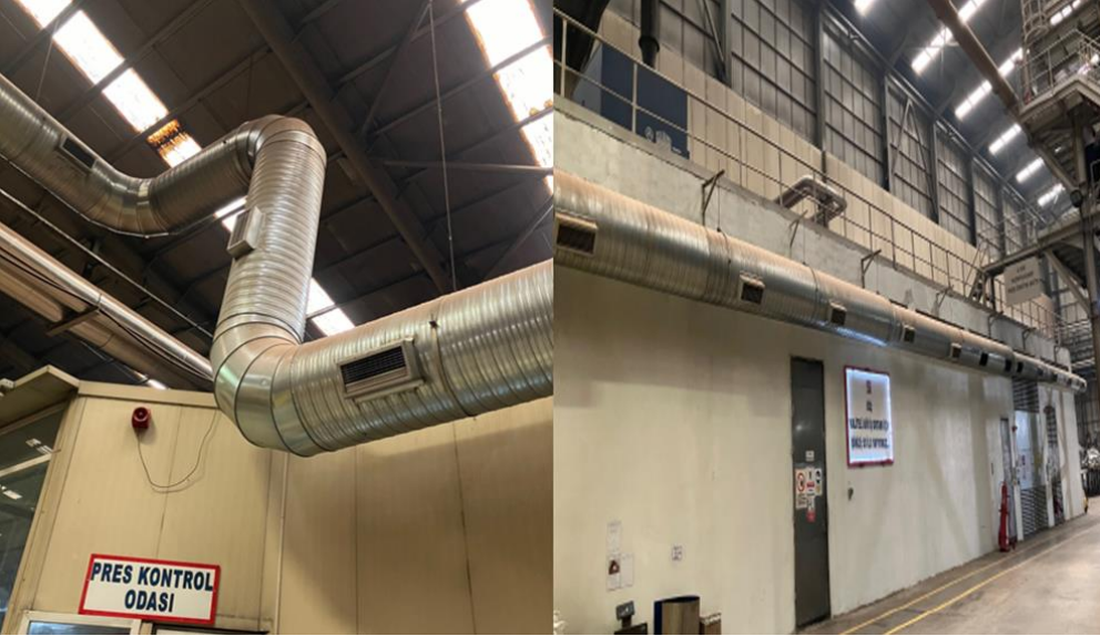
Şekil 7. Isıtma sistemi için form hattına kurulumu yapılan boru hattı ve menfezler
