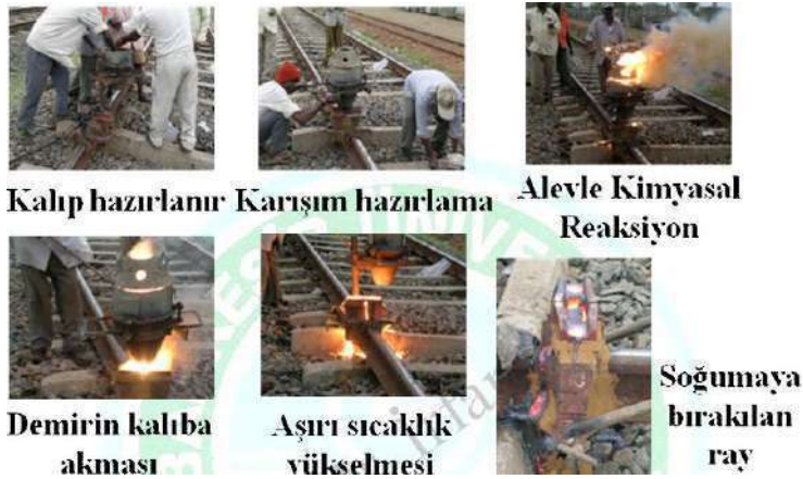
Şekil 9. Termit Kaynağı
